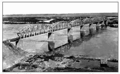
24 сентября 1915 г. железнодорожный мост через Обы принят в эксплуатацию. Длина моста 747 метров. Его проектировал инженер Е.К.Кнорре. На строительстве моста и подходов к нему было занято 2,5 тыс. рабочих.
