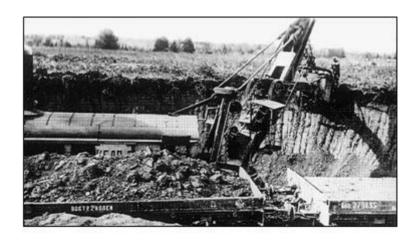
На земляных работах по разделке Гляденской выемки использовались два паровых экскаватора, махины весом по 70 тонн. Фото 1914 г.
